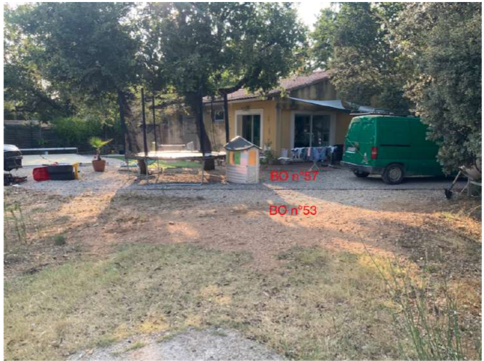
1. Bordure métal plantée en retrait de la limite séparative sur la parcelle 57
